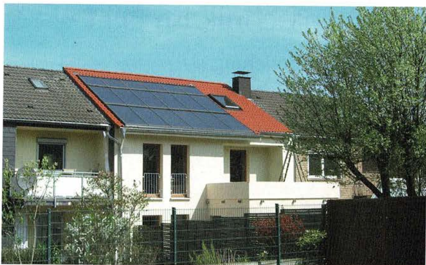
Energetische Sanierung zum Passiv-Reihenhaus
