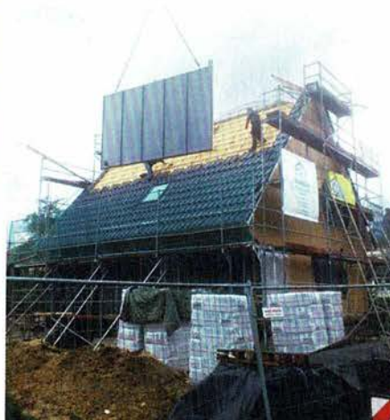
4 Die thermische Solaranlage wird auf das Süddach montiert
