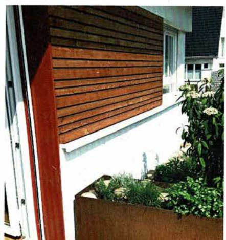
5 Detailansicht Fassade mit Holzverschalung
