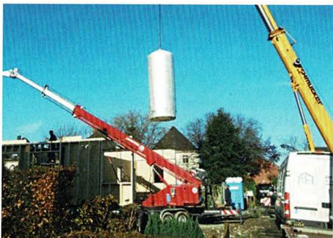
Der Speicher wird passgenau in die Deckenaussparung eingelassen
